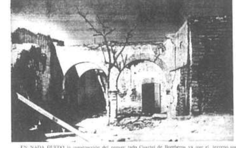
EN NAJADA QUEDÓ la construcción del primer budo Cuatrecasas de Durango, ya que el terreno que había sido cedido al Ayuntamiento de la Ciudad, resultó con defecto al estar por debajo del nivel del mar...
