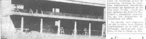
Esta por terminar la ampliación... En pocos días más concluyen los trabajos para iniciar en octubre, los trabajos para iniciar en octubre, los trabajos para iniciar en octubre
